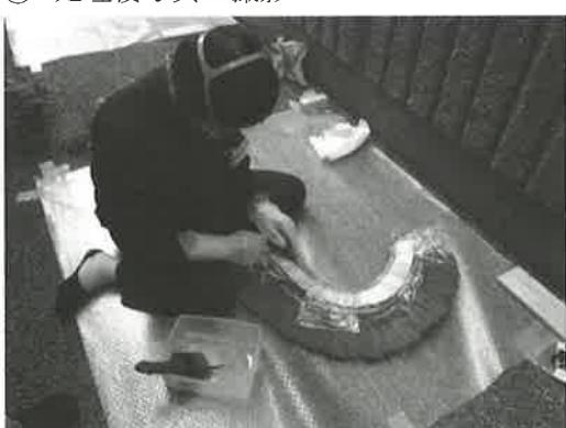
図-5 防腐防虫を目的とした薬剤塗布
