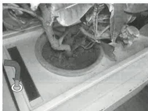
写真-4 雨水兼用型にも注水口が必要
