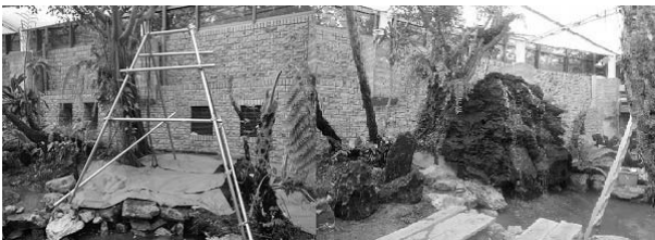
写真 - 5 滝の設置作業
