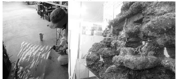
写真-3 擬岩製作状況(左：バーナーで変形、右：発泡ウレタンで製作した擬岩)
