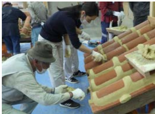
写真-6 赤瓦葺施工実習
