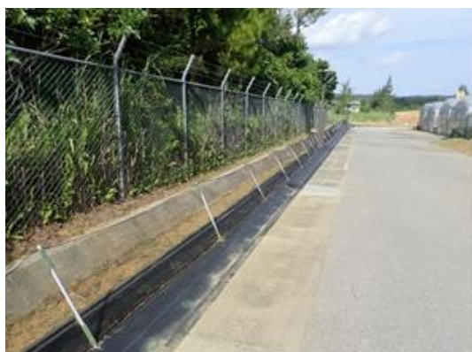
写真-1 侵入防止柵の様子
