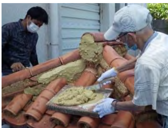
写真-4 赤瓦漆喰塗基礎 実習
