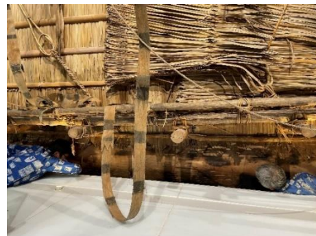
写真-1 ラカトイに発生したカビの拭き取り作業
