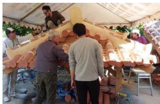
写真-4 赤瓦漆喰塗実習 製作架台
