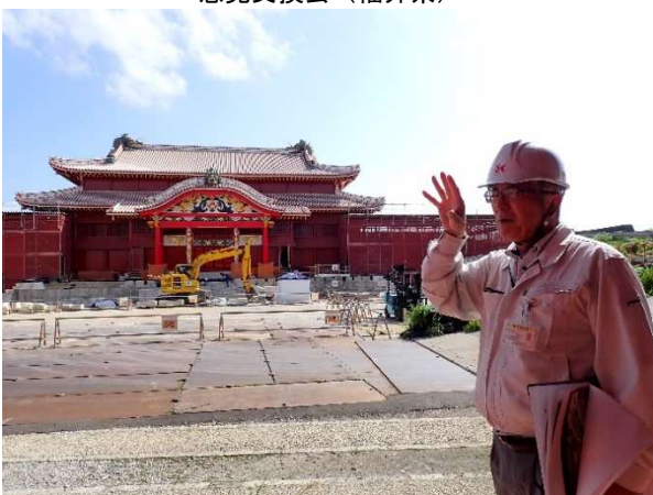
写真-10 首里城正殿復元工事現場視察
